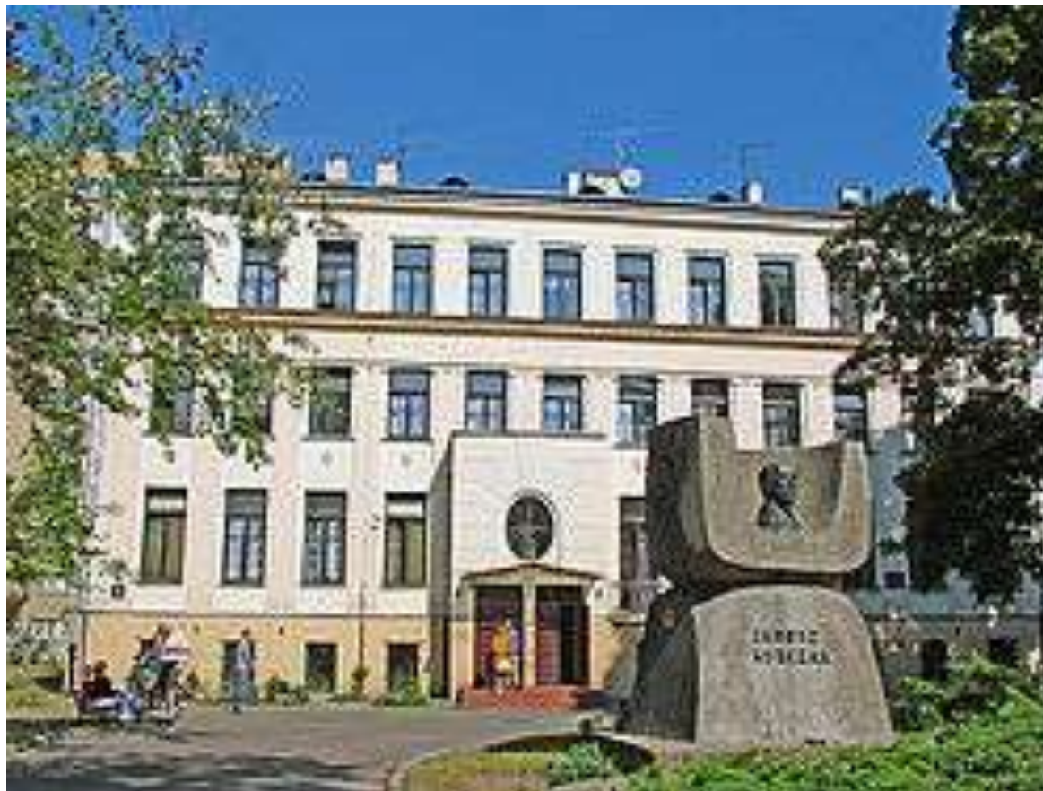
Widok Domu Sierot przed remontem w 2011 roku
